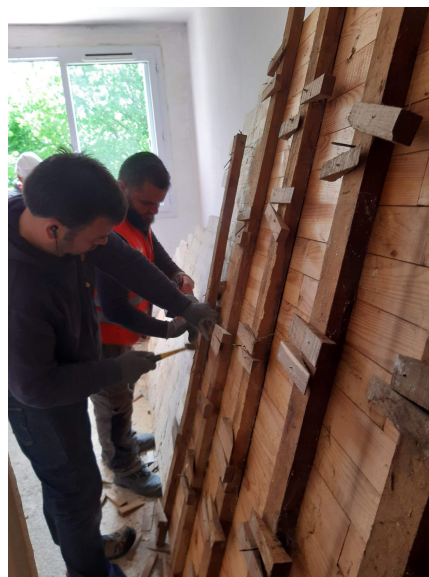
dépose sélective de parquet bois à Condé en Normandie
