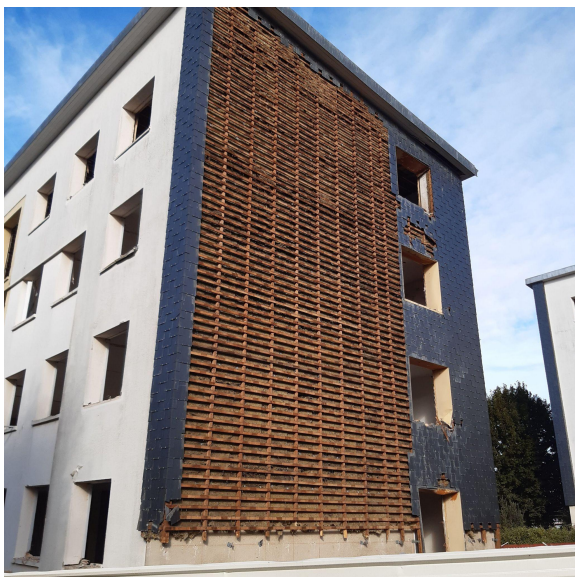
dépose sélective d'ardoises à Condé en Normandie
